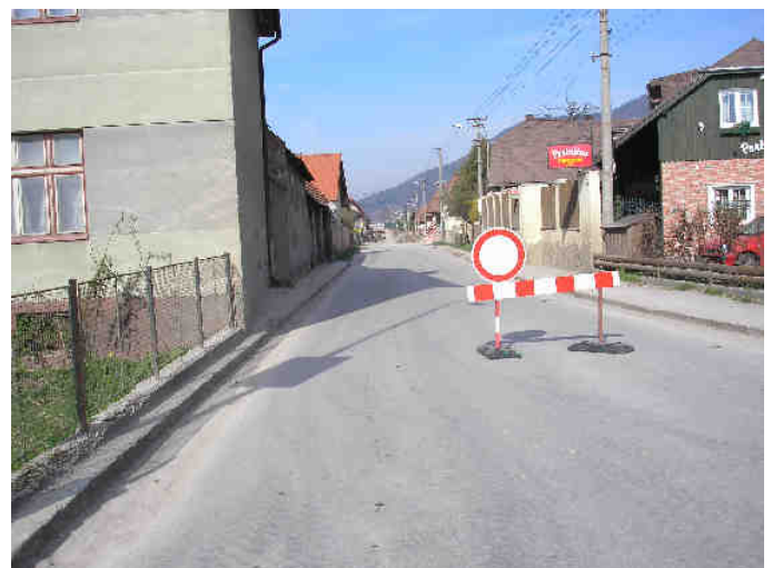
Budovanie kanalizačných a vodovodných prípojk na Fatranskej ulici
